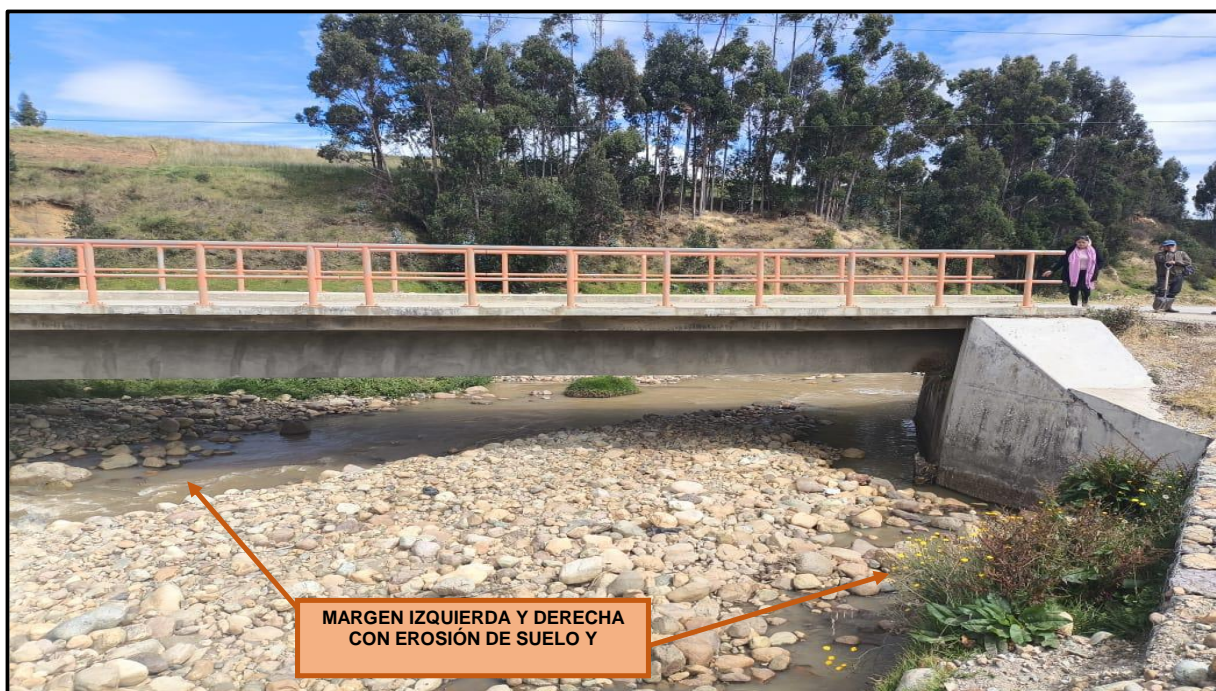
IMAGEN N° 02: PUNTO CRITICO DEL RIO CONOPA O MASMA EXPUESTO A DESBORDAMIENTO EN EL CERCADO DE LA POBLACION, PRODUCTO DE LA GRAN CANTIDAD DE MATERIAL COLMATADO EN TODO LA TRAYECTO DEL CAUCE DEL RIO CONOPA O MASMA.
